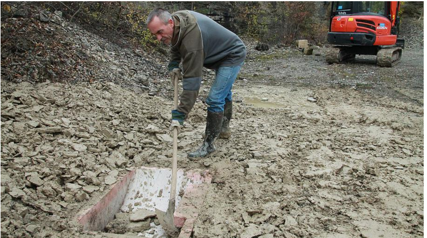
Foto: Karlheinz Haase | Im ehemaligen Steinbruch auf dem Ammerfeld legt Landschaftspfleger Peter Piesch letzte Hand an das frisch gesetzte Beton-Unkenbecken.
