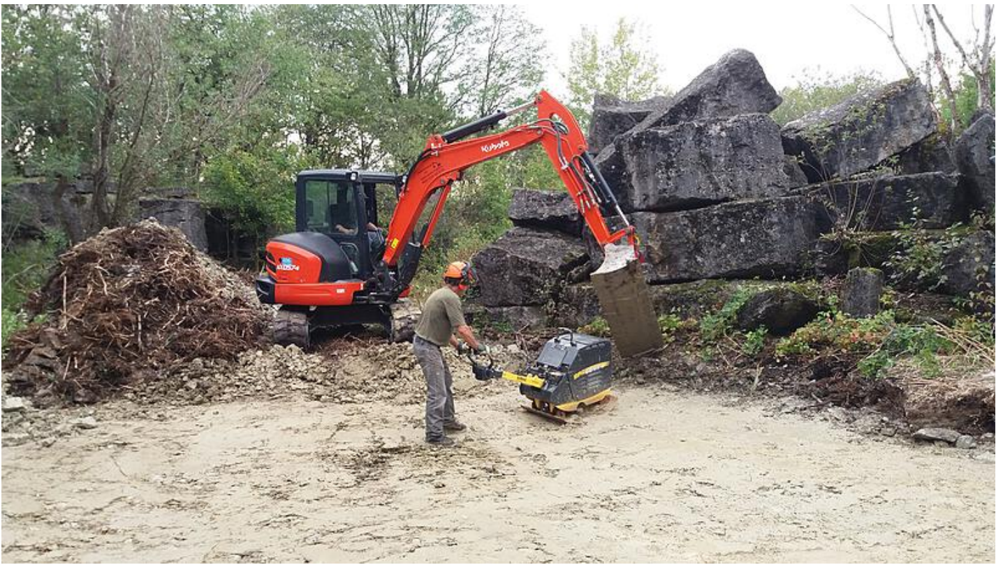
Foto: Christiane Brandt | In Lindelbach wurde mit der Rüttelplatte der Boden verdichtet, damit sich dort das Wasser länger hält.
